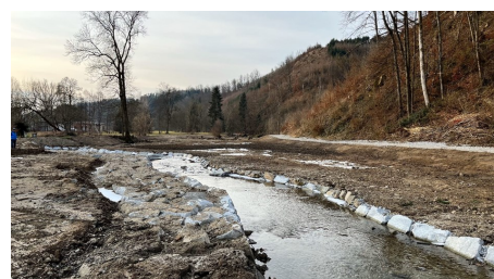
Ansicht der Einleitungsüberströmstrecke in den Eschelbach mit der anschließenden Vorlandabsenkung.
