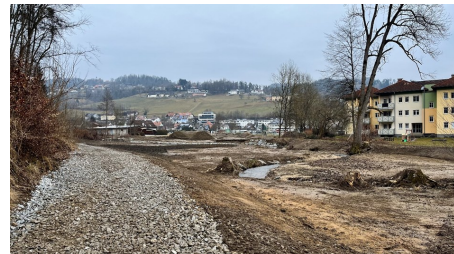
Ansicht der fertiggestellten Vorlandabsenkung im Bereich des Eschelbaches.
